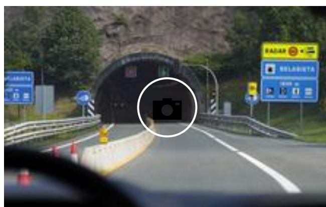
📷 Comienzan las obras del túnel de Belabieta, con una duración de 10 meses
